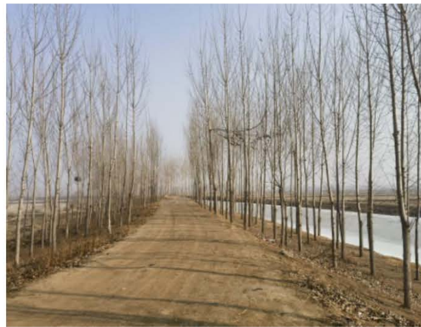
图 3-2 还乡河故道堤顶路现状
