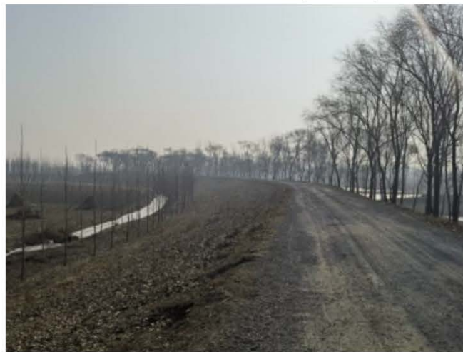
图 3-3 双城河左堤堤顶路现状
