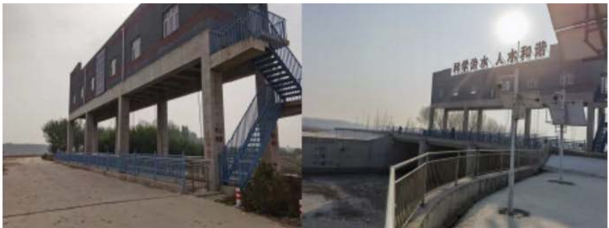
图 3-5 九丈窝分洪闸现状
