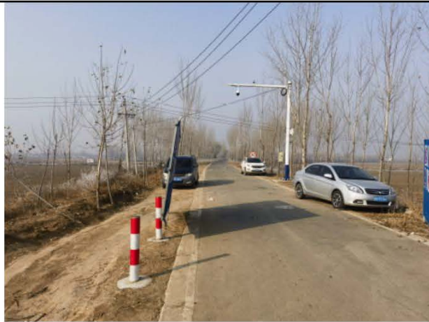
图 3-1 还乡河大堤堤顶路现状
